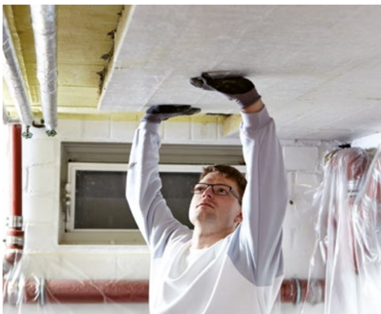
Die Kellerdecke kann wirtschaftlich von unten gedämmt werden. Die Platten werden geklebt. Einzelne Hersteller bieten vorkaschierte Platten mit fertiger Untersicht an. © Rockwool
