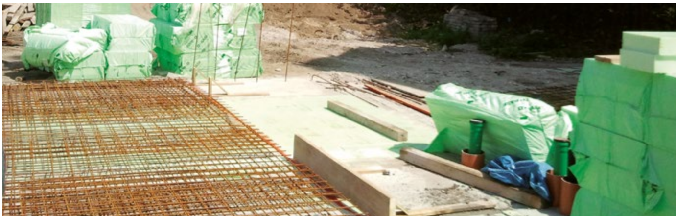
Beim Neubau werden druckfeste Polystyrolplatten unter die Bodenplatte verlegt werden, die dann gut gegen Wärmeverluste gedämmt ist.
